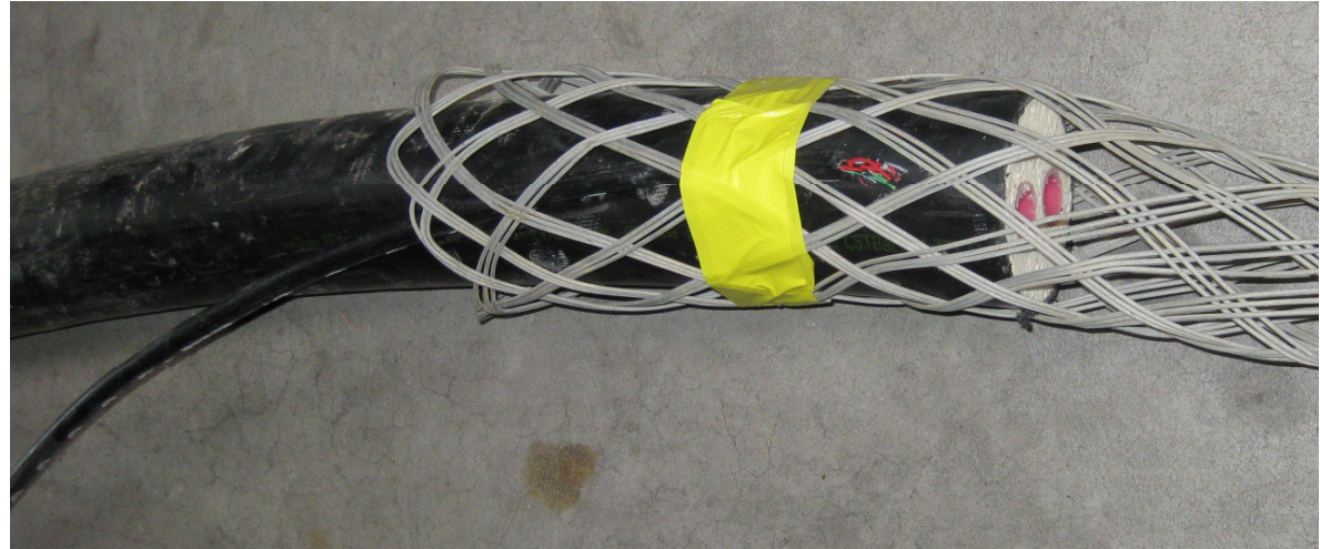
Abbildung: Einzug mit Kabelzugstrumpf und Datenkabel
